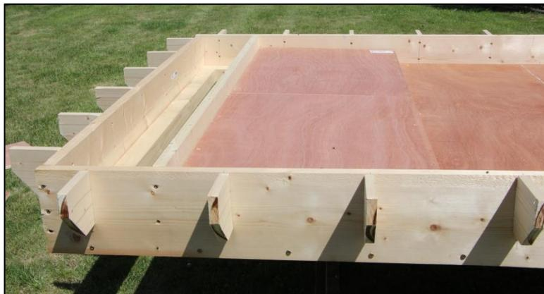
Continuons avec la pose des bords du bassin (9a, 9b, 7 et 8). Les pièces qui constitueront les bords du fond seront découpées dans les panneaux de 244x122x18 (9a et 9b).
